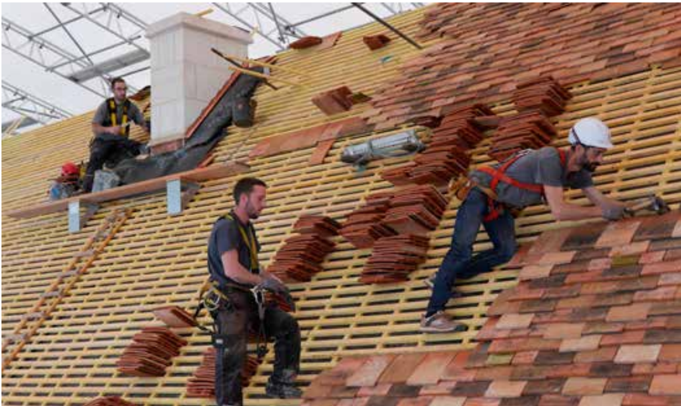
Restauration de la toiture à l'abbaye de Royaumont (Val d'Oise)
